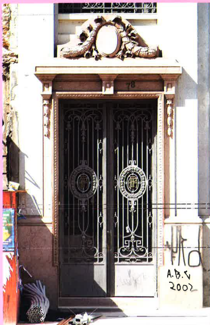
Edifício Lutetia - entrada Foto: Fernando A. Silveira
