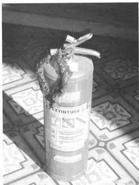
Extintor inutilizado
