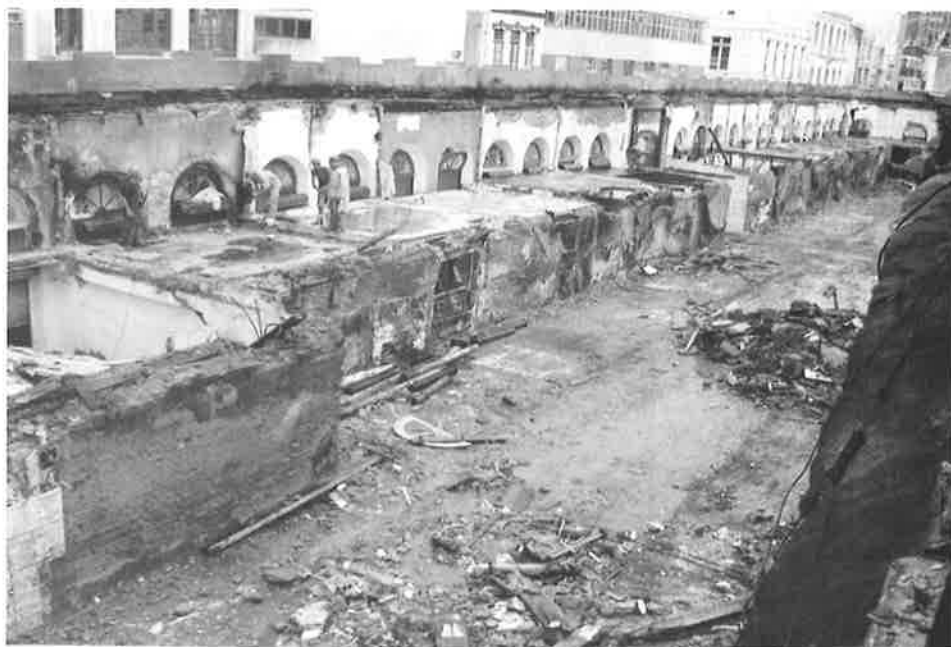
Vista parcial do Mercado após incêndio
