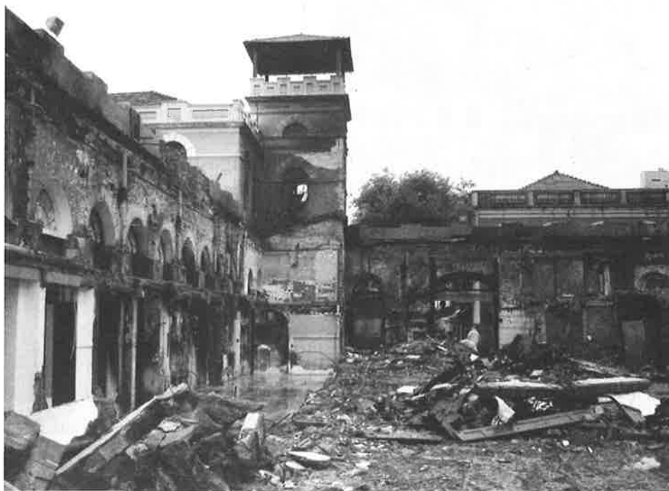
Vista parcial do Mercado após incêndio
