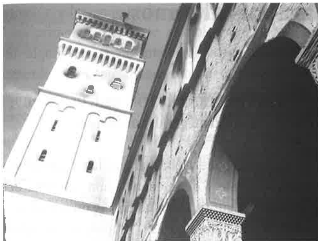
Torre atingida pelo fogo
