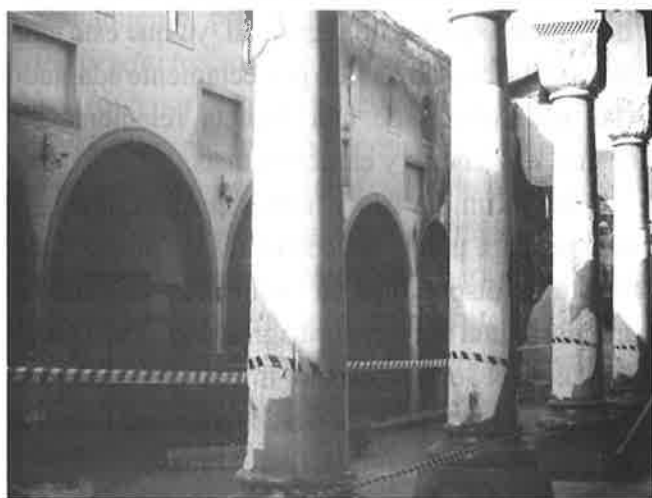
Vista parcial da nave destruída
