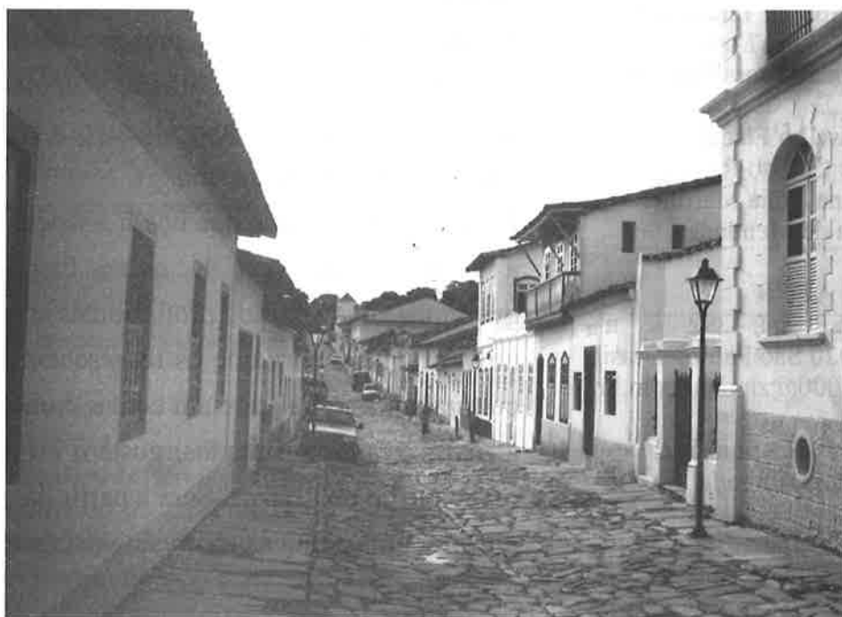
Rua de Goiás, cidade declarada pela UNESCO, Dez. de 2001, Patrimônio Cultural da Humanidade. Em janeiro de 2002 uma enchente do Rio Vermelho destruiu parte do centro histórico, danificando 80 prédios tombados. A cidade foi recuperada através do Projeto Monumenta.
