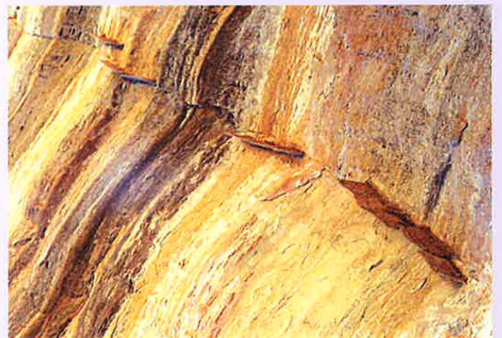
Pingadeiras para desviar a água da chuva
